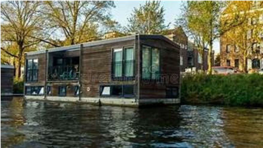
FIGURA 4. Casa Flotante de los Países Bajos - Resiliencia ante Inundaciones
